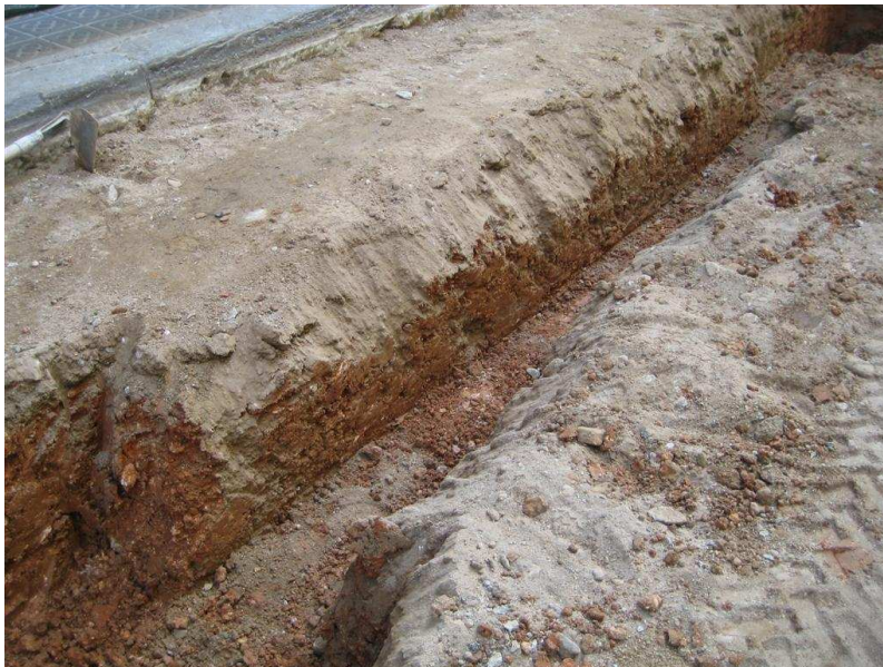
Vista des del nord de la rasa que uneix dos embornals E 13
