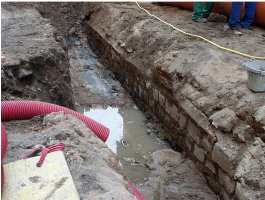
Vista de la paret del col·lector UE 301
