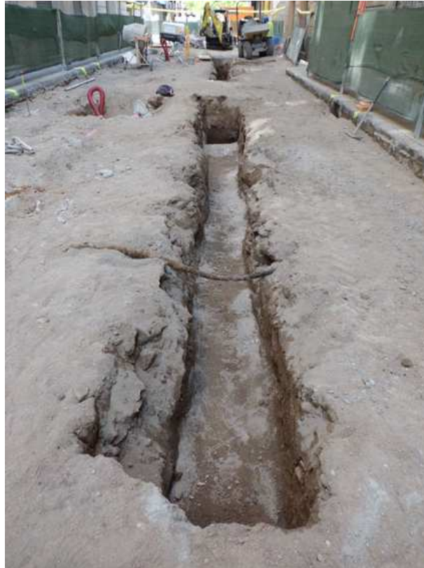
Vista de la rasa 200 per instal·lar els elements que formen el sistema de desguàs de les aigües superficials i pluvials del carrer
