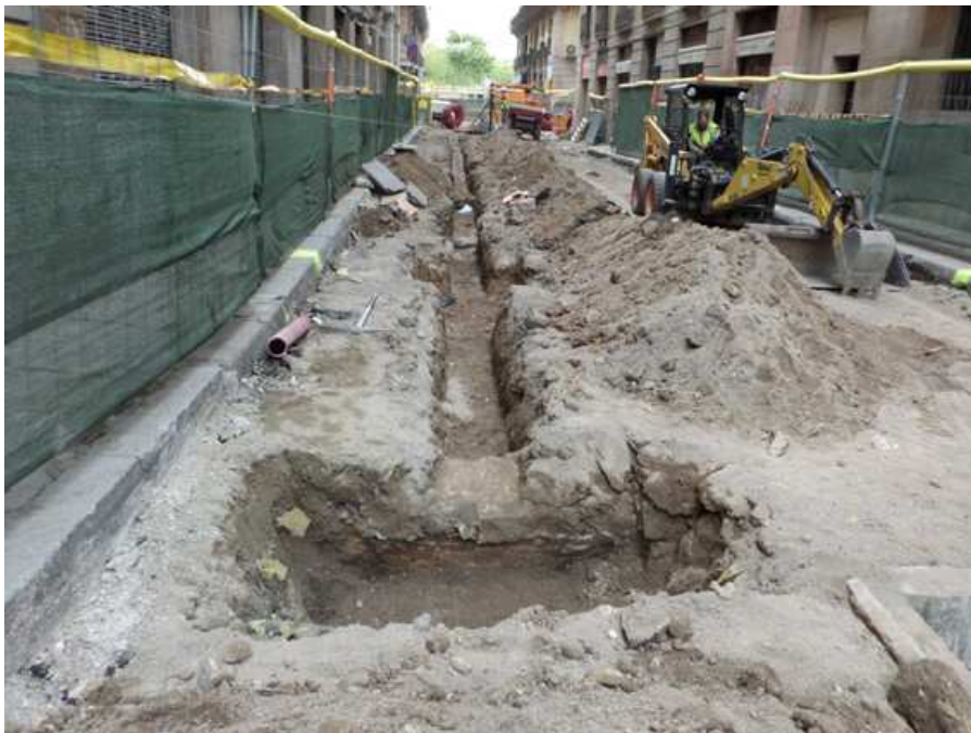
Vista de la rasa 100 per instal·lar l'enllumenat públic (fanals), el cablejat de fibra òptica, electricitat i el tub de rec pels arbres que es plantaran al carrer
