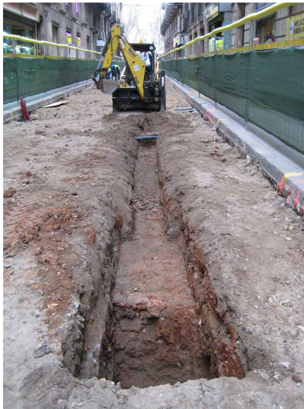
Procés d'excavació dels forats i rases per als embornals
