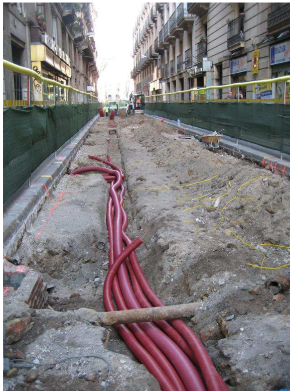
Vista des del sud-oest de la col·locació dels tubs de serveis
