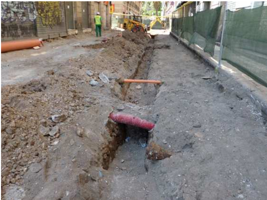
Vista de la rasa 400 per instal·lar l'enllumenat públic (fanals), el cablejat de fibra òptica, electricitat i el tub de rec pels arbres que es plantaran al carrer
