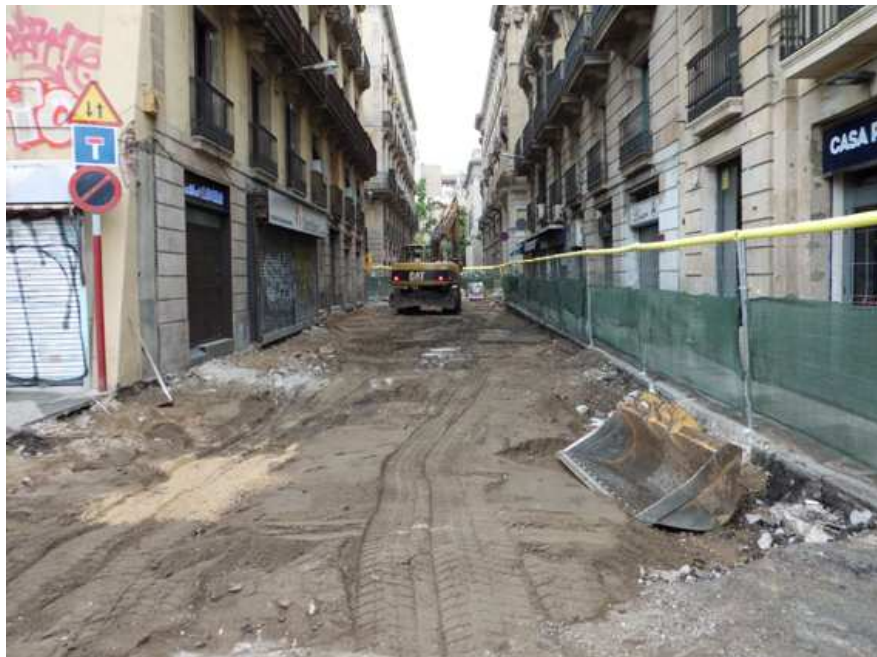
Vista del carrer Llauder en el tram que va del carrer Pas sota muralla i Reina Cristina
