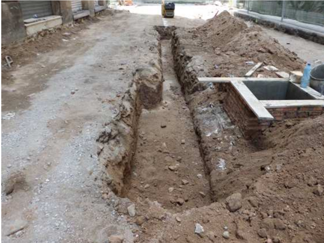
Vista de la rasa 500 per instal·lar els elements que formen el sistema de desguàs de les aigües superficials i pluvials del carrer
