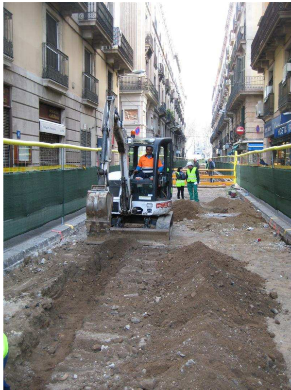
Procés d'excavació de les rases serveis
