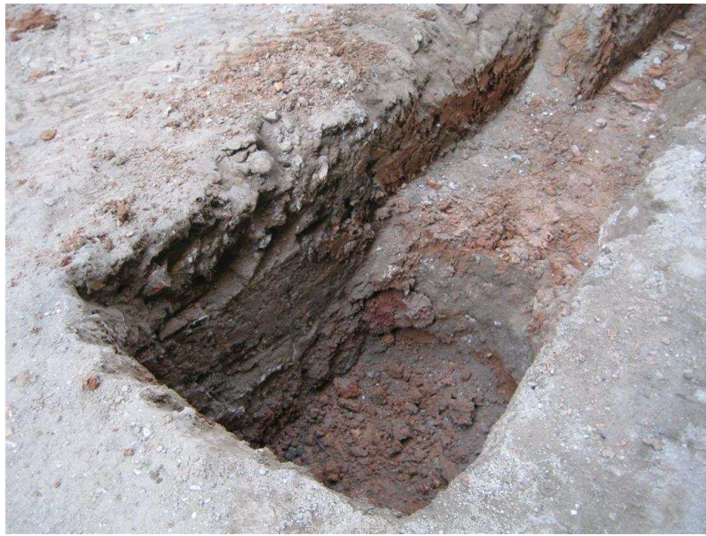
Vista des del sud del retall per col·locar el tub que desguassa al col·lector central i per a la col·locació d'un embornal E 14
