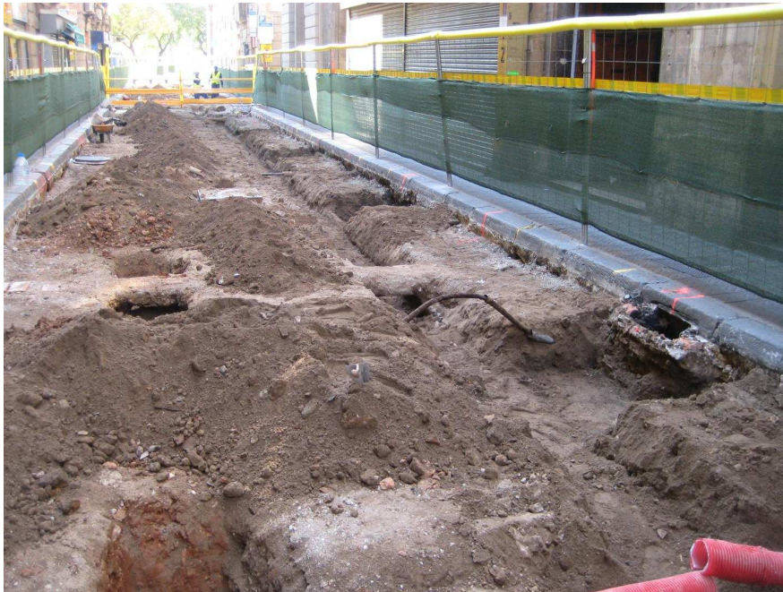
Vista general des de l'est de la rasa i els forats per l'enllumenat públic.
