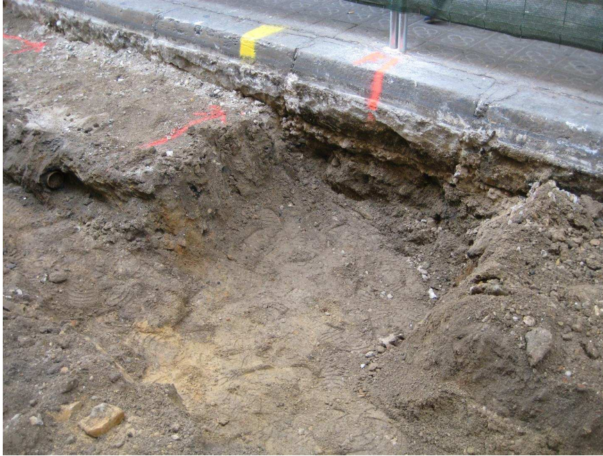
Vista des de l'est del forat per a la col·locació de un fanal FF 6
