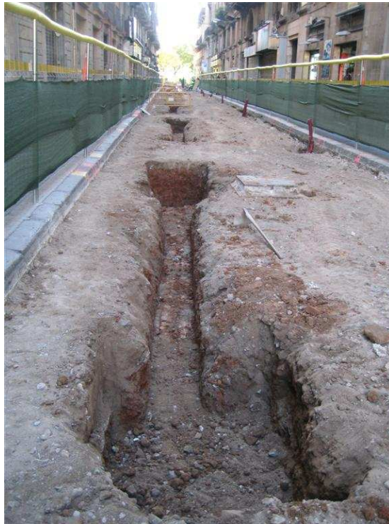
Vista general des del nord-est dels rebaixos dels embornals
